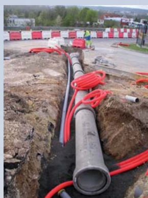
Travaux de réseaux
