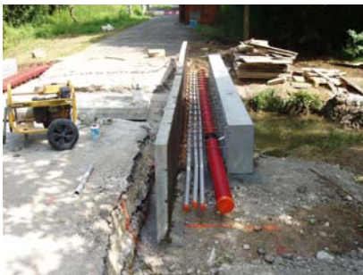
Longrine GC, fourreaux, coffrage trottoir
