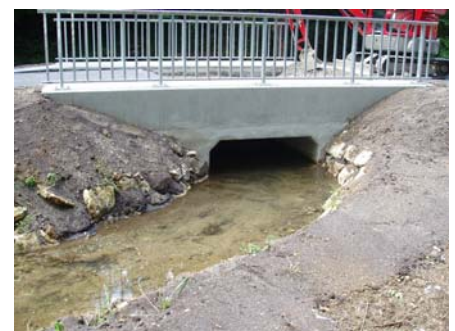
Confortement des berges en enrochement
