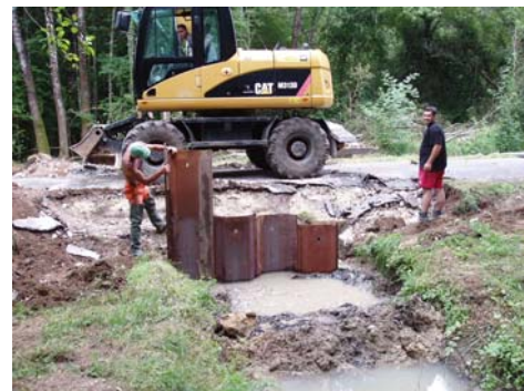
Réalisation parafouille (palplanches PU6)
