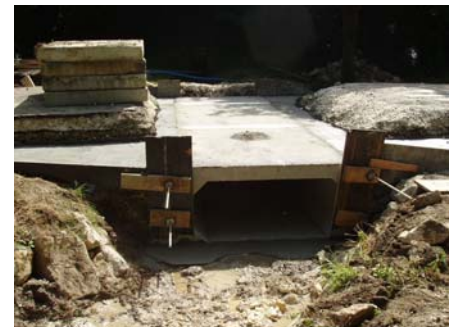
Bétonnage des piédroits
