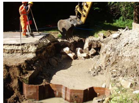
Démolition et décaissement
