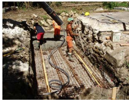
Bétonnage semelle (radier)
