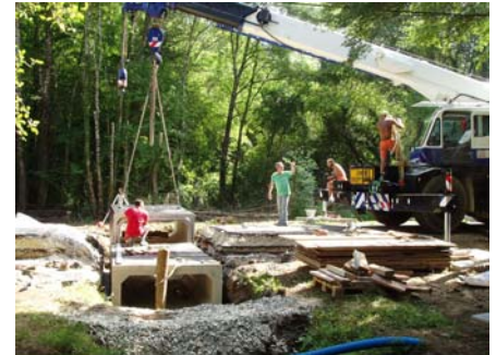
Pose des buses préfabriquées
