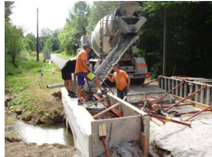
Bétonnage trottoir
