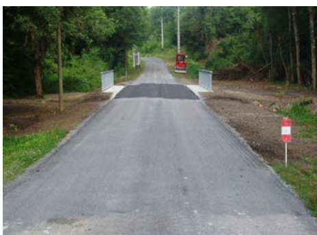
Ouvrage après travaux
