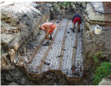
Ferraillage semelle de répartition
