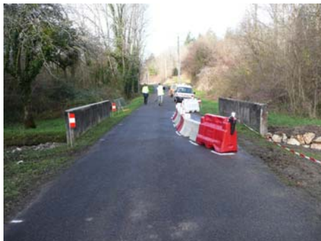
Ouvrage avant travaux
