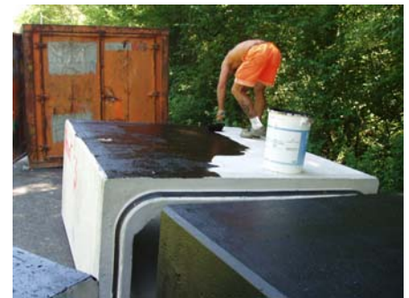
Étanchéité des buses préfabriquées
