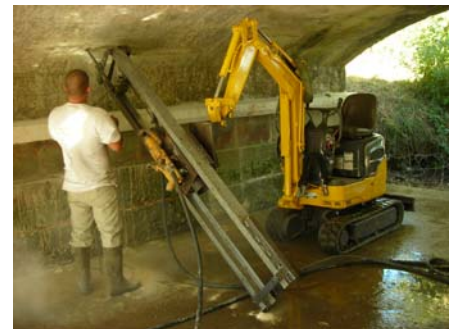
Réalisation barbacanes : 3 par naissance
