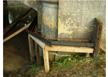
Passage vison : Ferrailage et coffrage
