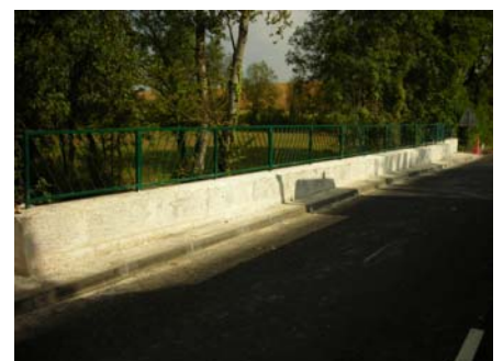
Trottoir aval avec garde corps
