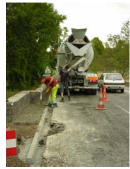
Trottoir aval : bétonnage trottoir
