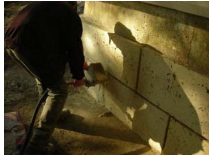
Rejointoiement des maçonneries
