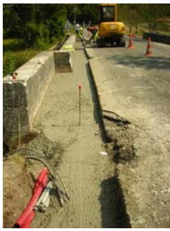
Trottoir aval : implantation bordures
