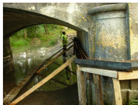
Coffrage et ferrailage corniche vison d'Europe
