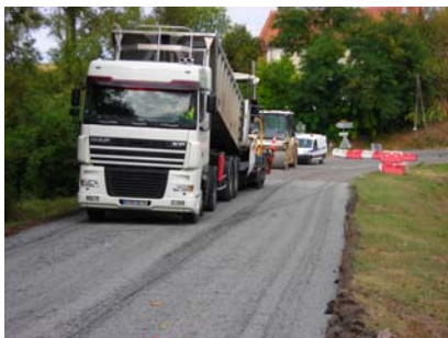
Couche de roulement après rabotage
