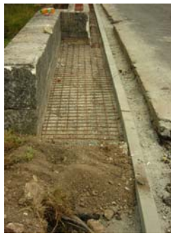
Trottoir aval : bordures + ferrailage trottoir
