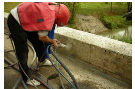
Hydroblasting du parapet
