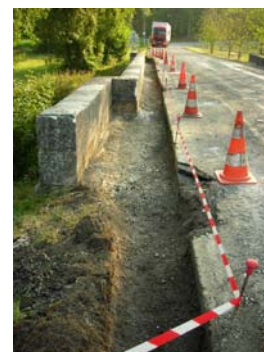
Trottoir aval : Sciage chaussée et terrassements
