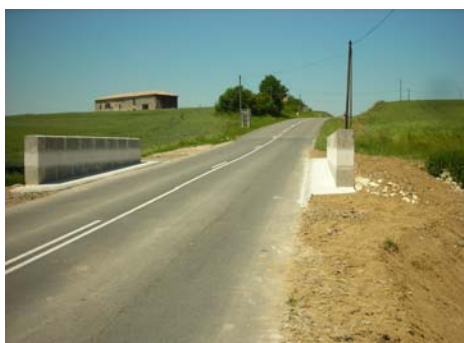
Vue de l'ouvrage après travaux2
