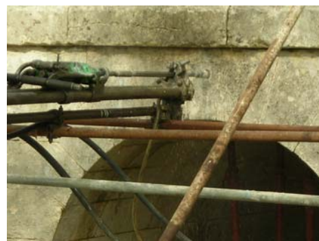
Forage des barres d'ancrage
