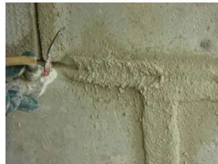
Rejointoiment des maçonneries à la lance
