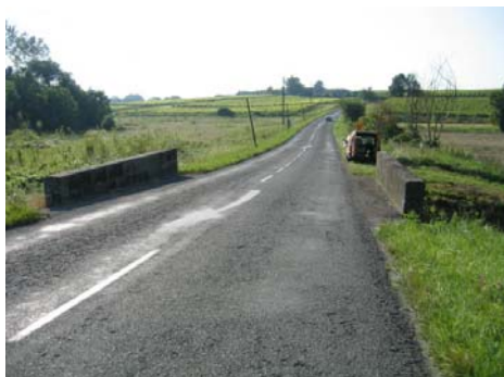
Vue de l'ouvrage avant travaux
