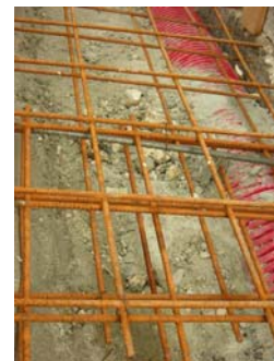
Ferrailage du trottoir
