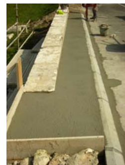
Bétonnage du trottoir finition talochée
