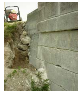
Extrémité mur en retour en béton armé
