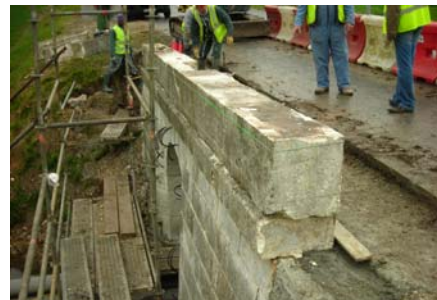
Repose du parapet aval
