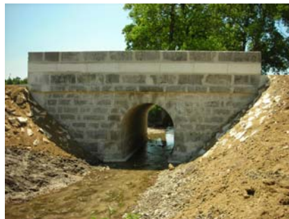
Élévation amont après travaux
