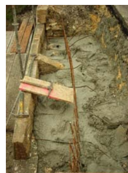
Remontage mur en retour
