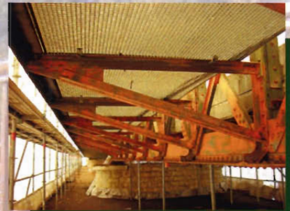
Ossature après décapage
