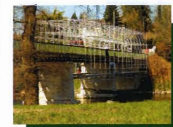
Mise en place de l'échafaudage
