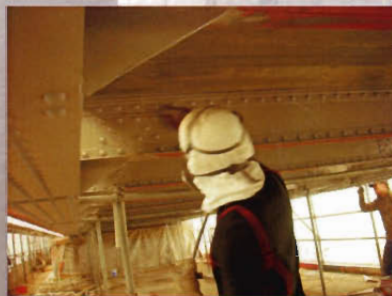
1 ère couche mise en oeuvre
