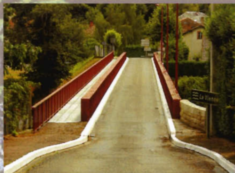
Vue générale - ouvrage terminé
