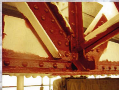
Couche de finition en cours
